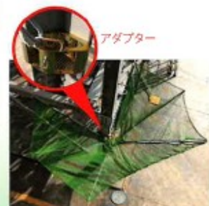
山形鋼鉄塔における取付状態
