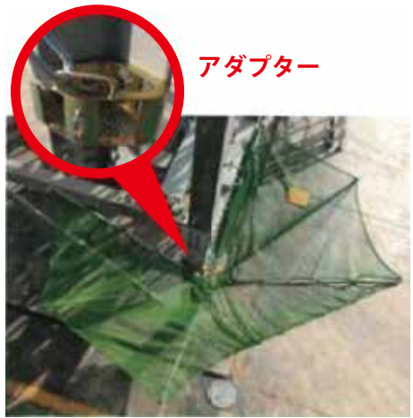
山形鋼鉄塔における取付状態
