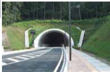
施工 3 ヶ月経過
