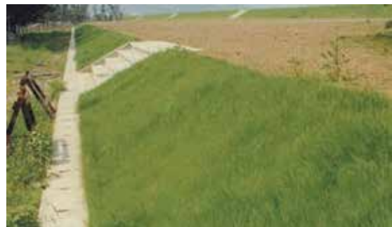
施工 5 ヶ月経過
