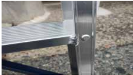
溶接による踏み桟の補強部
