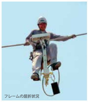
フレームの屈折状況
